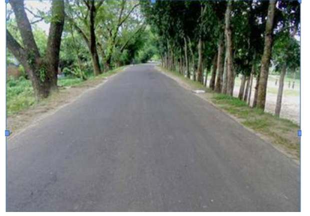
সময়ান্তর রক্ষণাবেক্ষণের পরে নগরকান্দা জিসি-চাঁদহাট জিসি সড়ক, উপজেলাঃ নগরকান্দা, জেলাঃ ফরিদপুর।
