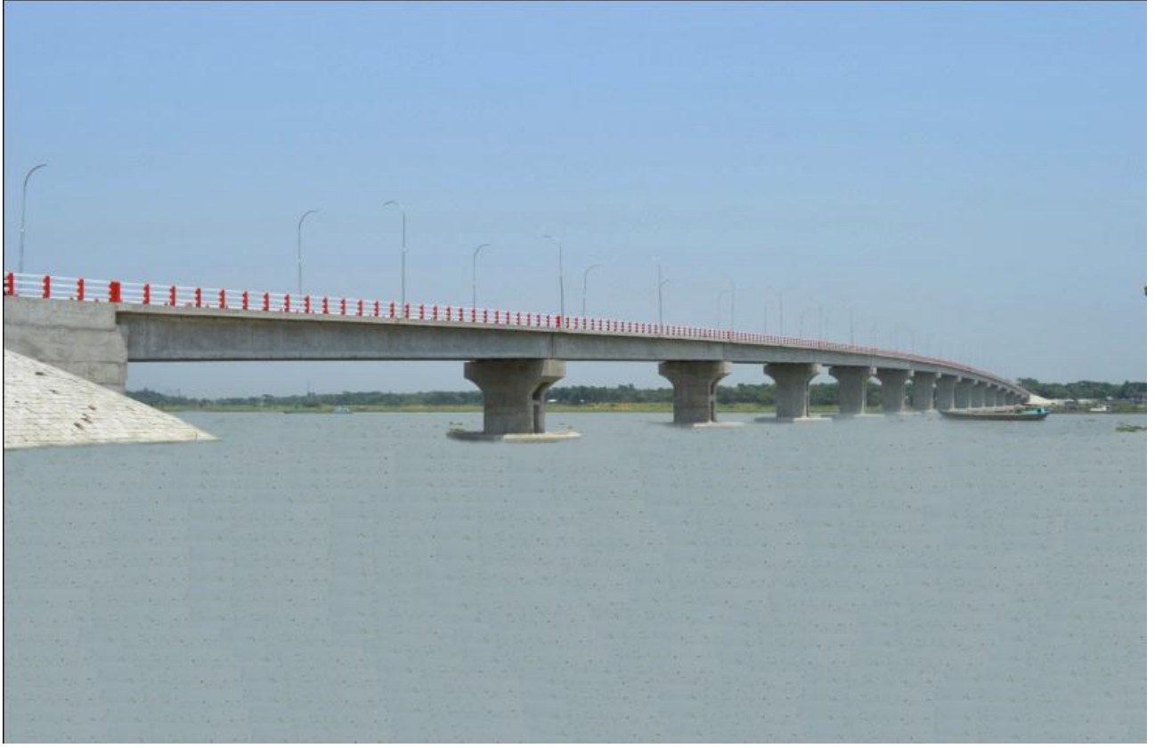
গোপালগঞ্জ সদর উপজেলায় গোপালগঞ্জ-সিংগাতি রাস্তায় মধুমতি নদীর উপর চাপাইল ঘাটে ৫৮৮.৬৫ মিটার দীর্ঘ প্রিস্ট্রেসড কংক্রীট গার্ডার সেতু
